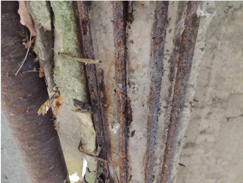
Koroze krajního nosníku na nátokové straně
