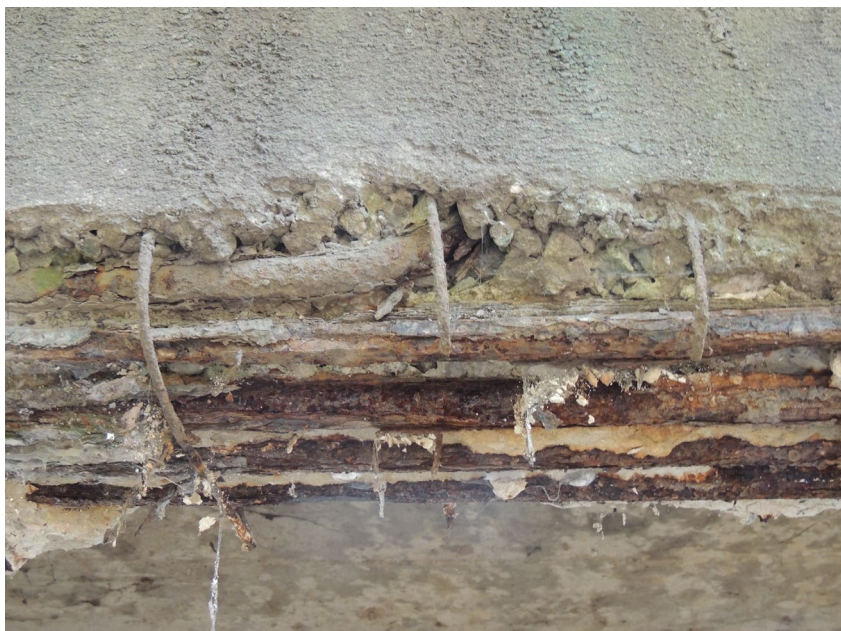
Ohyb prutu v horní vrstvě za příčným trámem
