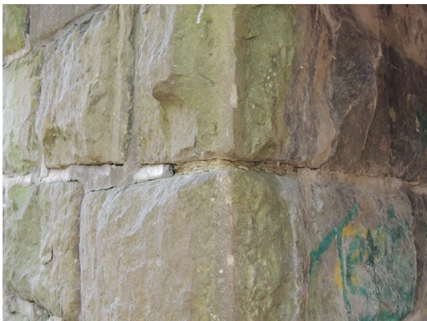
Vydrolená zdící malta opěry
