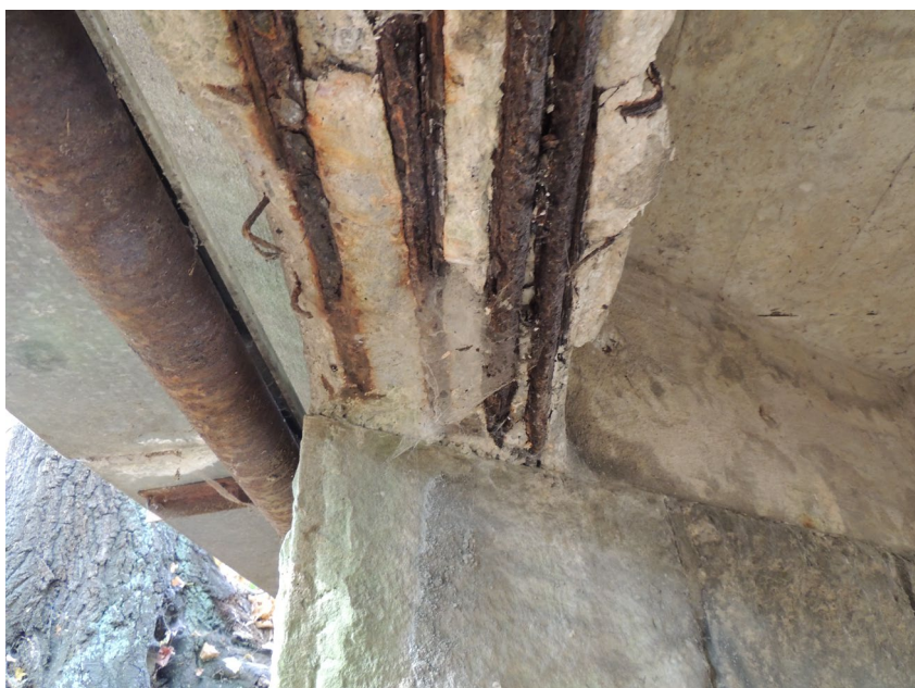
Koroze výztuže krajního nosníku na odtokové straně
