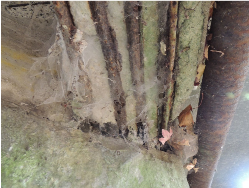
Výztuž krajního nosníku na odtokové straně u podpory
