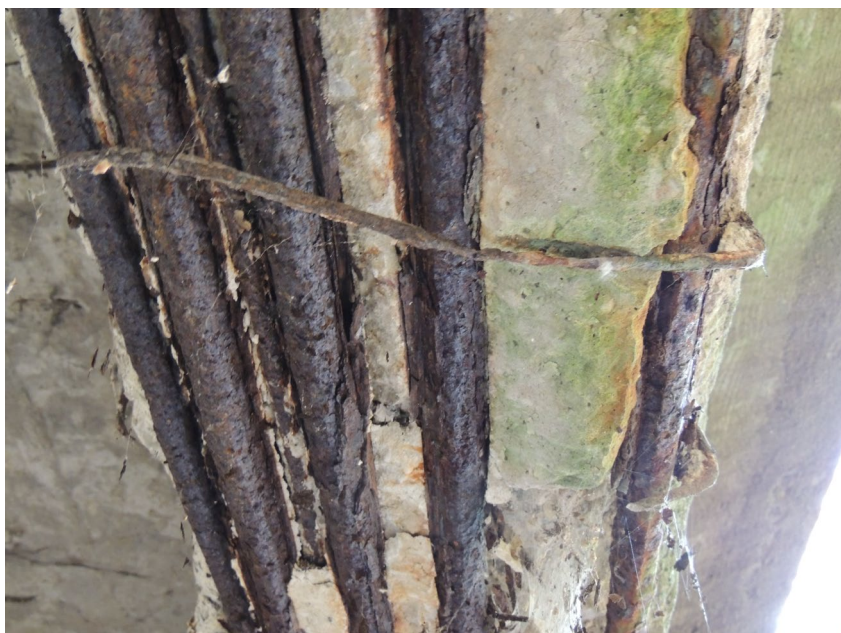
Koroze výztuže na krajním nosníku na nátokové straně
