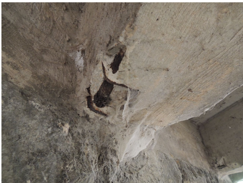
Koroze výztuže vnitřního nosníku u podpory
