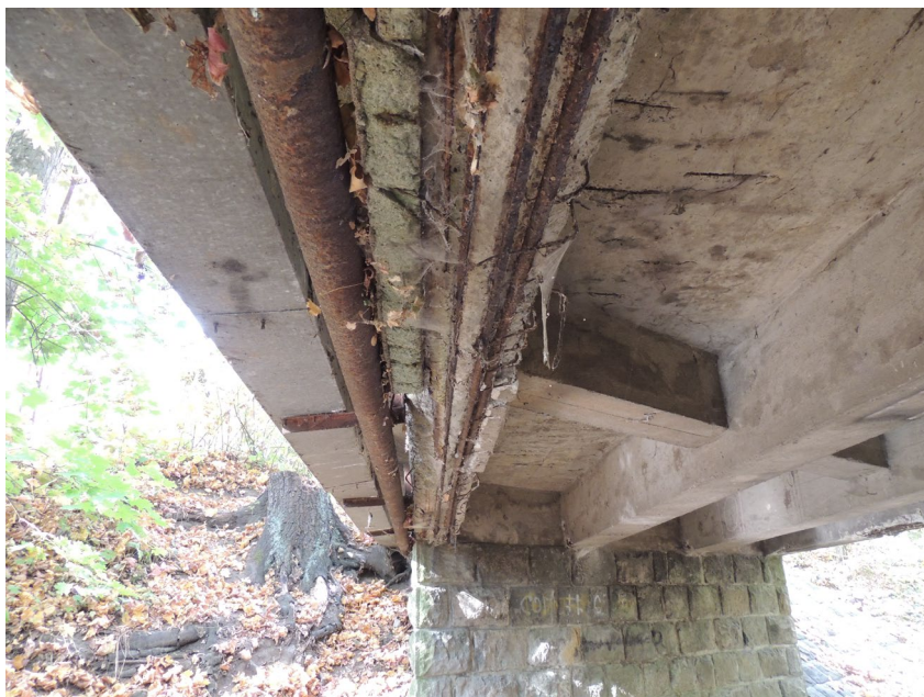
Koroze krajního nosníku na nátokové straně
