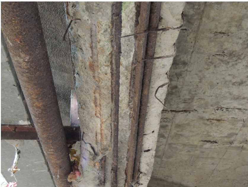
Koroze výztuže a přerušené třmínky krajního nosníku na odtokové straně
