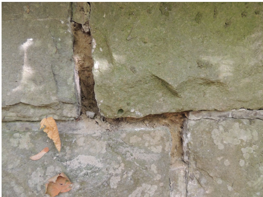
Vydrolená zdící malta opěry
