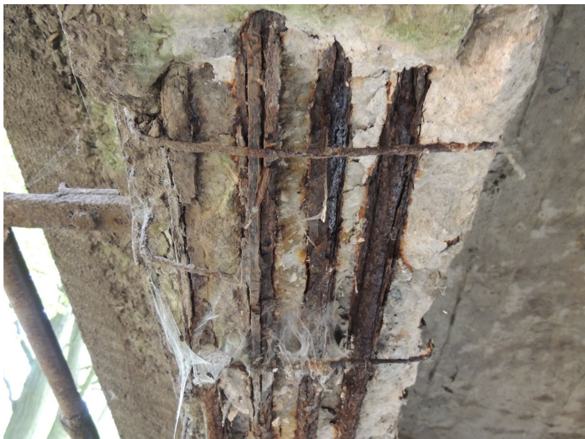
Koroze výztuže krajního nosníku na odtokové straně
