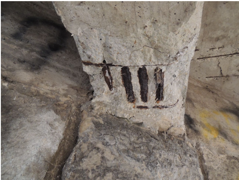
Výztuž vnitřního nosníku u podpory
